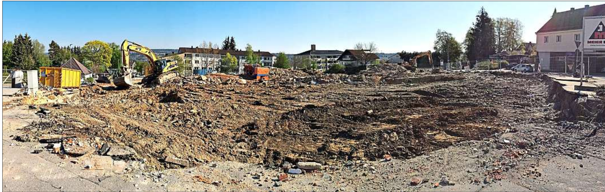
Wo zuletzt viel abgerissen und weggeräumt wurde, kann jetzt ohne jegliche juristische Bremsmanöver aufgebaut werden. Auf dem Areal des einstigen Pell-Centers soll bis voraussichtlich Sommer 2017 das neue Stadtteilzentrum „Neustift-Center“ entstehen. – Foto: Karl
